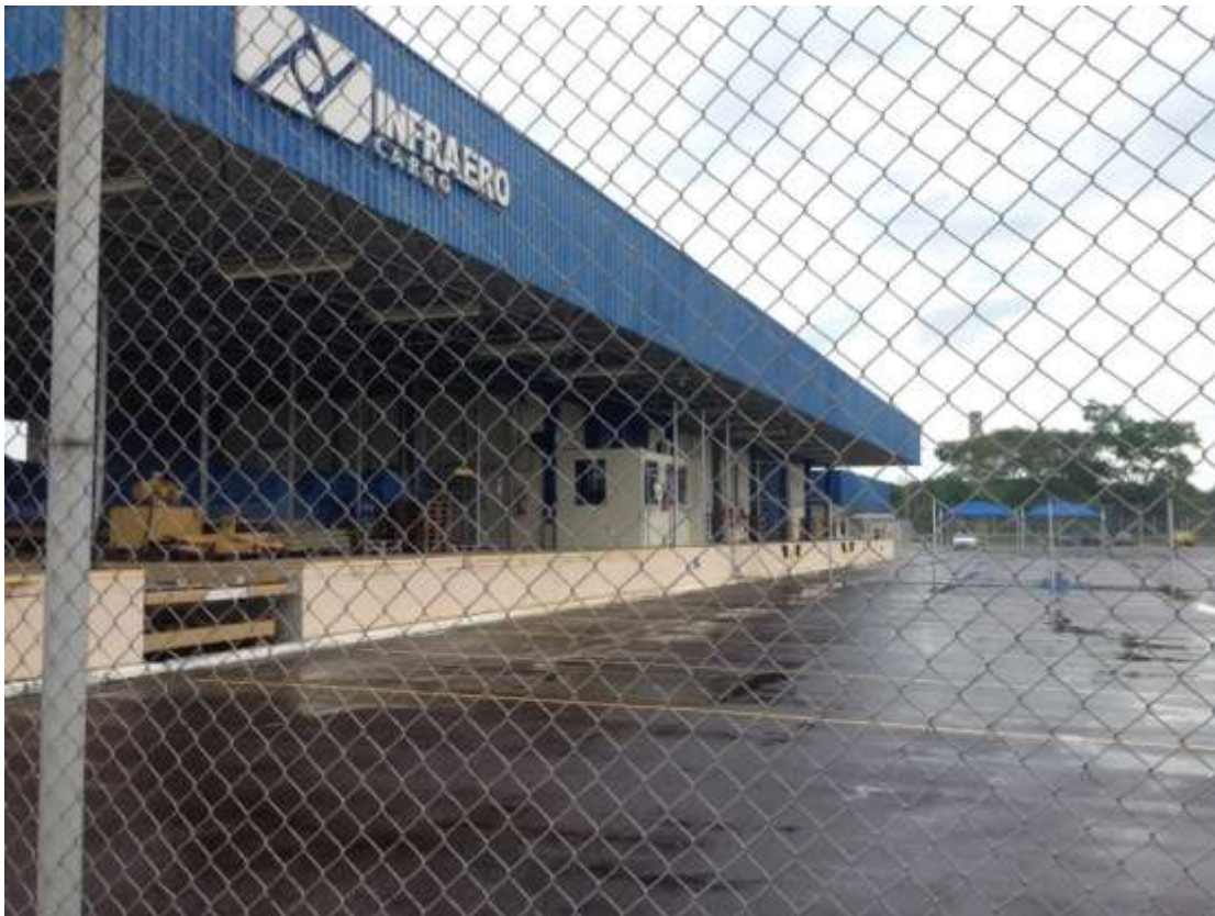
Fachada do TECA
